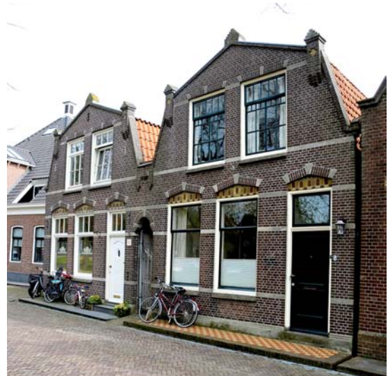
Geschakelde woningen, gebouwd omstreeks 1900. Het rechter huis heeft nog de oorspronkelijke vensterindeling, van het linker huis zijn de ramen gemoderniseerd (Matthijs Tinxarach 5-6 Edam).
