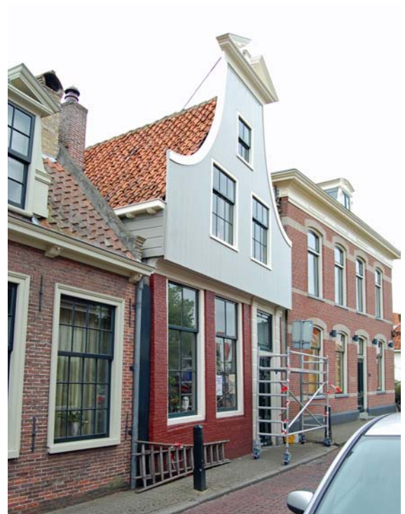
De houten topgevel van dit huis is later toegevoegd (Spuistraat 31 Edam).
