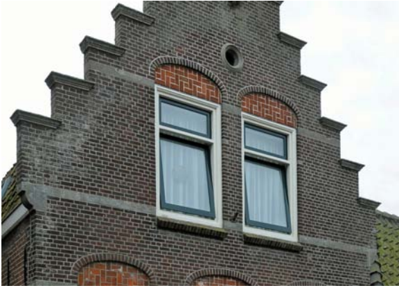
De zoldervensters in deze topgevel zijn gemoderniseerd met vaste kalven en taatsramen. Daardoor is het historische beeld verschaald (Lingerzijde 47 Edam).
