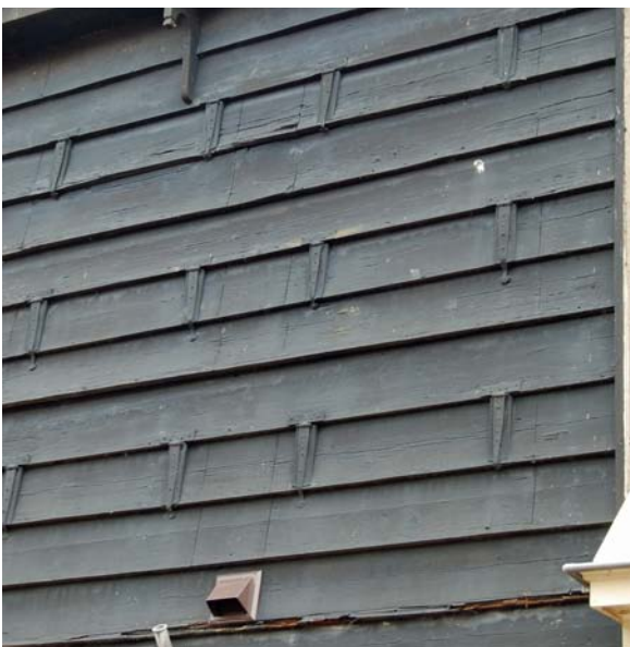
In de houten wand van dit pakhuis aan de Gevangenpoortsteeg in Edam zijn verticaal draibare luiken opgenomen.
