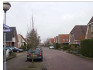
De nokrichting dient of haaks op, of parallel aan de straat te zijn
