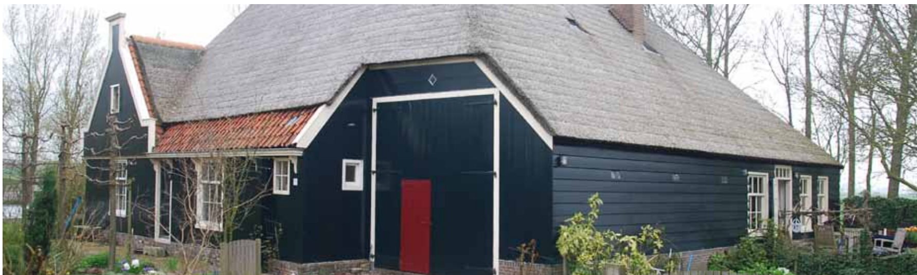
Transformatie van een stolpboerderij (Beets)
