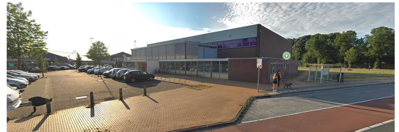
Bestaande sporthal welke gesloopt zal gaan worden.
